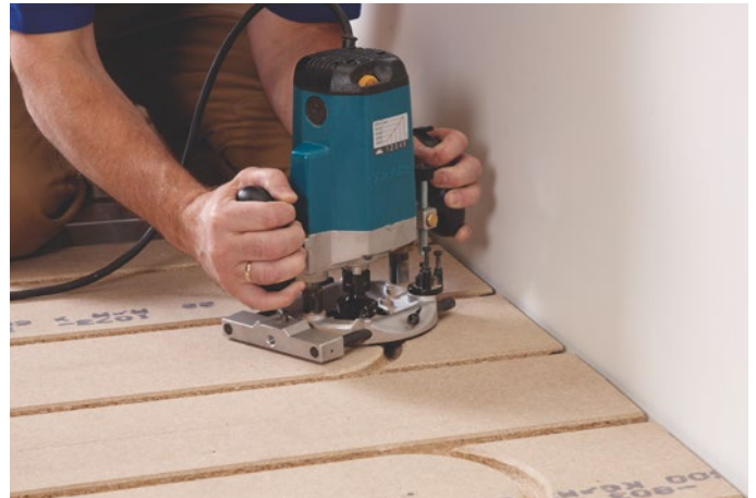
Figur 7 Fräsning av vändspår i varannan rad.
