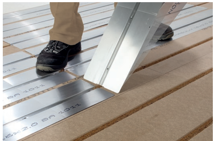
Figur 9 Värmefördelningsplattorna kan monteras/läggas stående.
