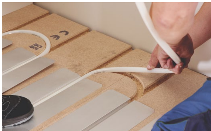
Figur 10 Montering av värmeslangar.
